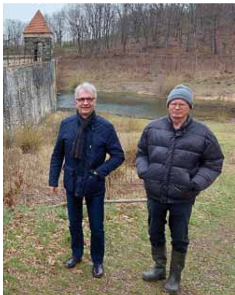
Unsere Stadträte Steffen Wegert (l.) und Günter Boden bei einer Besichtigung der Talsperre Euba. Foto: AfD
